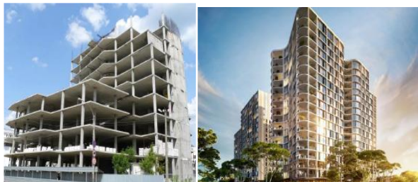
Рис. 1.1 Примеры строительства многоэтажных зданий с монолитным железобетонным каркасом
