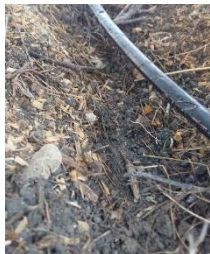
Рис.13 - Установка эмиттерной ленты
