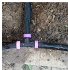
Рис. 12-Установка фитингов
