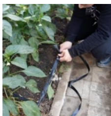
Рис. 11 - Монтаж трубопровода системы капельного полива по рассаде
