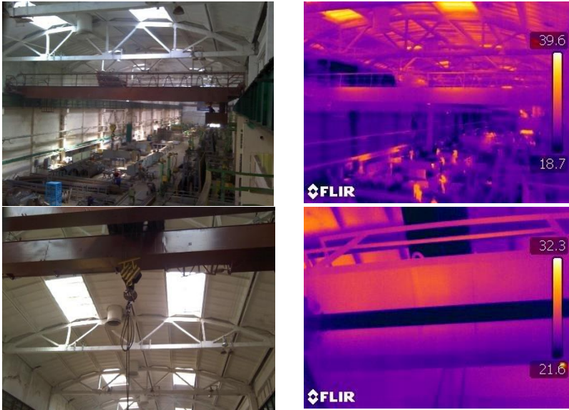
Рис. 5 - Проведение тепловизионного обследования металлоконструкций мостового крана предприятия ООО «Новоросметалл»
