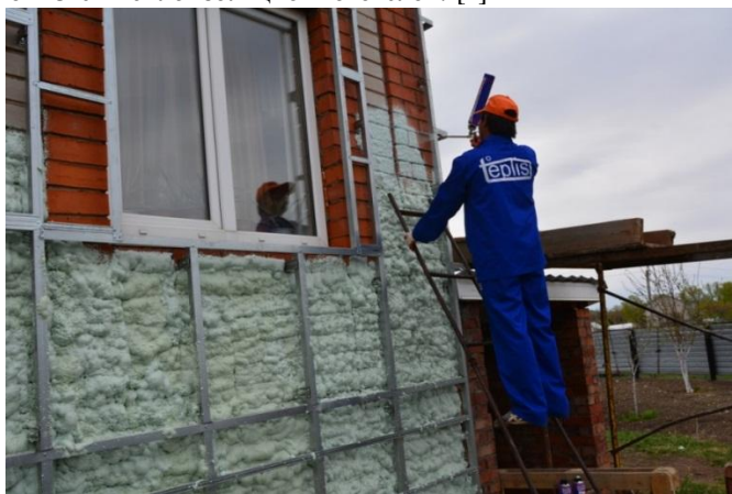
Рисунок 8. Утепление с помощью напыляемого ППУ «Теплист»
