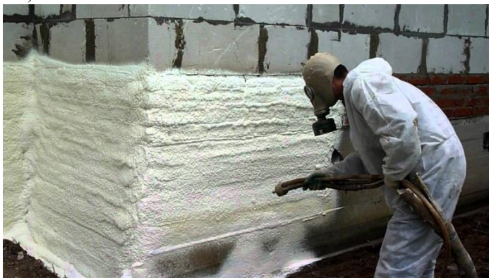
Рисунок 7. Напыление ППУ на цоколь дома
