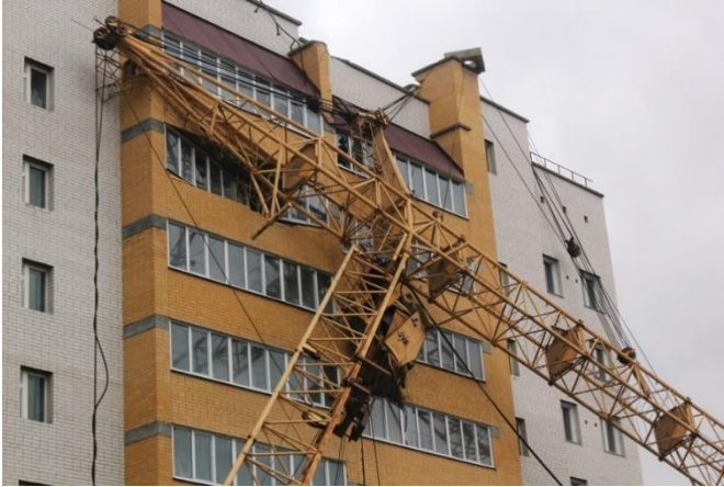
Рис.1. Авария башенного крана
